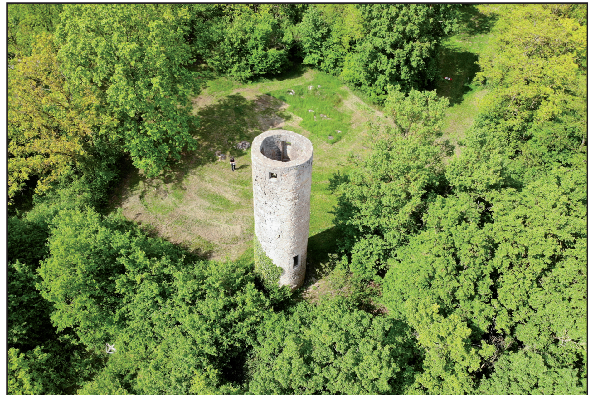
Wartturm oberhalb von Kleinochsenfurt, Luftbild von Süden (Anfang 15. Jh. errichtet) https://wuerzburgwiki.de/wiki/Wartturm_Kleinochsenfurt
